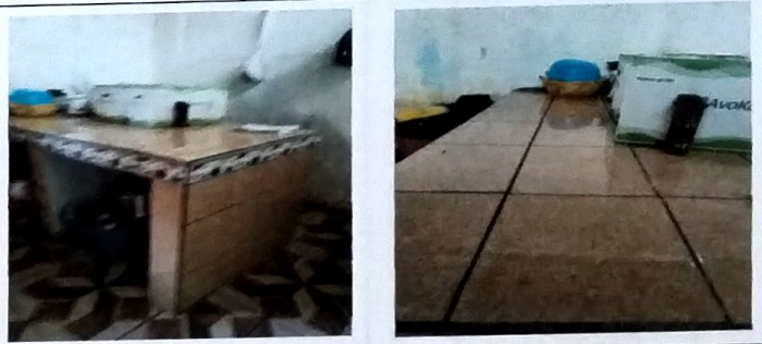
Foto 10: Modulo de Cocina ejecucion de mueble de concreto con aplicacion de azulejo en muros y superficie.
