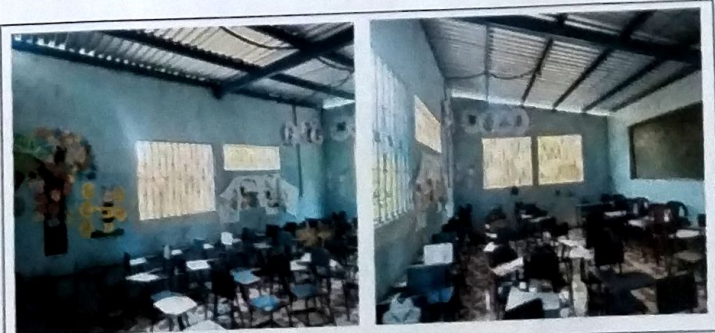
Foto 6: MODULO C Suministro e instalación de lamina troquelada cal 26 + mantenimiento de estructura de metal, apertura de vanos en muros e instalación de balcones de metal.
