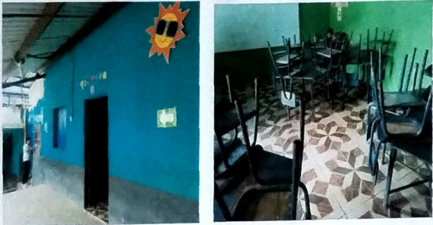
Foto 7: MODULO D aula Instalacion de piso ceramico
