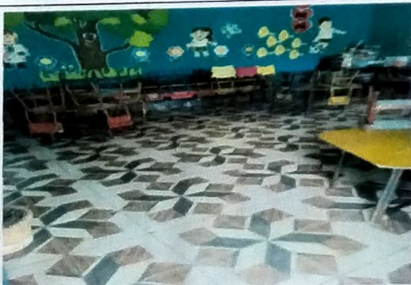
Foto 11: MODULO E Suministro e Instalacion de Piso Ceramico.
