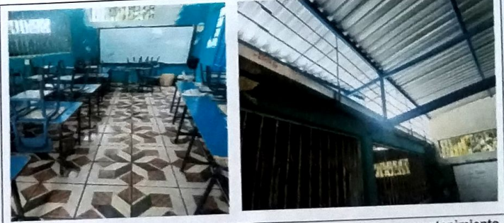
Foto 4: MODULO B Suministro e Instalación de piso Ceramico mas mantenimiento de balcones en vanos de ventatas. Suministro e Instalación de canal de metal con sus pescantes e Instalación de estructura de metal a base de costaneras + lamina troquelada cal 26.
