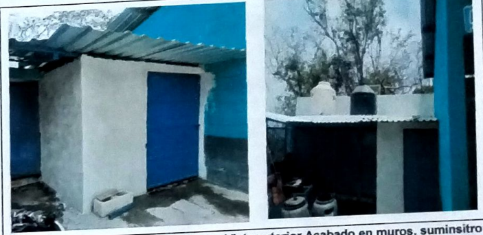
Foto 2: MODULO B Servicio Sanitario. Vista exterior Acabado en muros, suministro e instalación de puerta de metal y Colocación de costaneras de metal y lamina troquelada cal 26.
