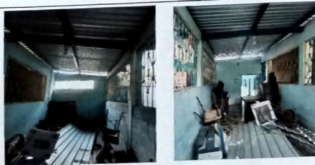
Foto 5: MODULO B Suministro e Instalación de estructura de metal a base de costaneras e instalación de lamina troquelada cal 26.
