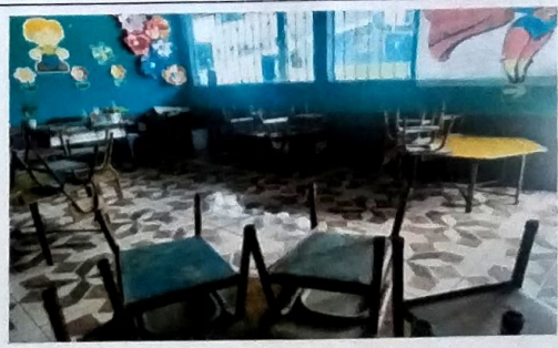
Foto 12: MODULO E Suministro e Instalacion de Piso Ceramico.
