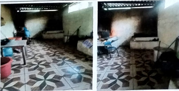
Foto 9: Suministro e instalacion de piso ceramico en area de cocina
