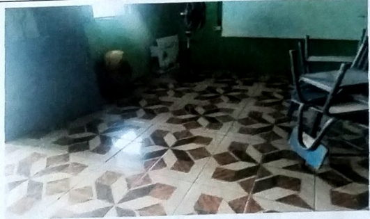
Foto 8: MODULO DE aula Suministro e instalacion de piso ceramico.
